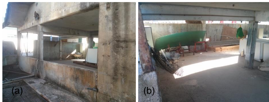
Figura 1 - Fotos do local de construção das paredes.
