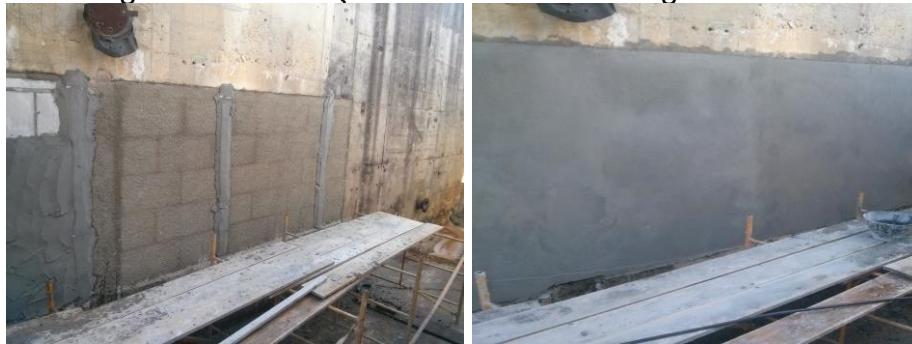
Figura 3 – Execução do revestimento argamassado.
