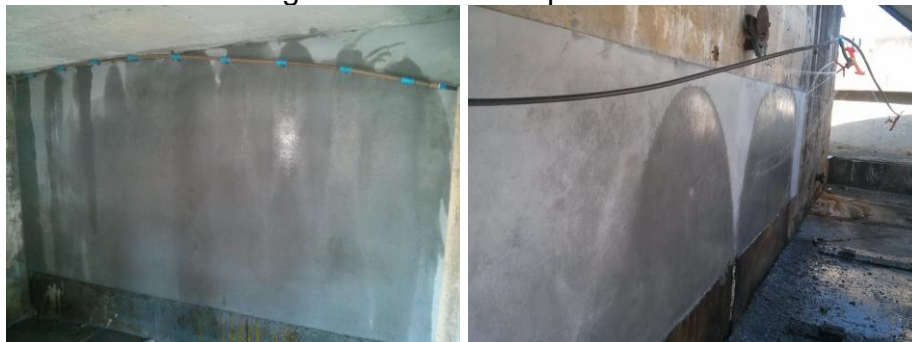
Figura 4 – Cura das paredes.
