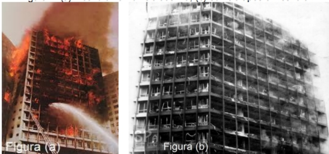
Figura 2 - (a) incêndio no Edifício Joelma; (b) edifício após o incêndio
