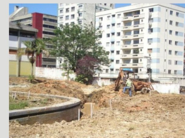
Imagem do aterro feito em 2006 na piscina do Criciúma Esporte Clube, para dar origem ao estacionamento do estádio. FONTE: site Engeplus.
