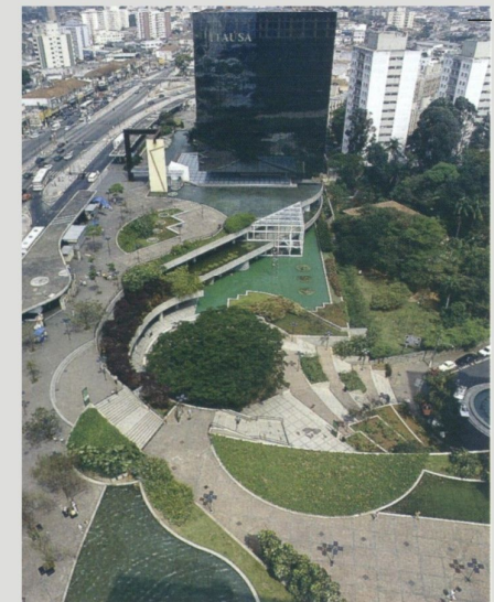
A praça seca e a relação com os edifícios. FONTE: www.arcoweb.com.br
