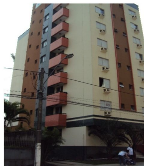
6- Edifício de 8 pavimentos FONTE: Autora
