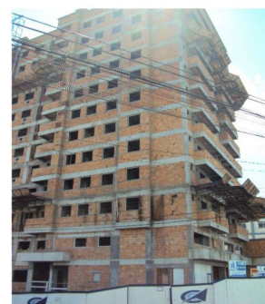
7- Edifício de 12 pavimentos FONTE: Autora
