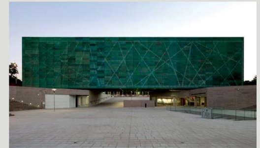
A parte superior da edificação possui três pavimentos distribuídos em quatro apoios. FONTE: www.arcoweb.com.br
