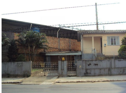
5- Residência vizinha do Estádio FONTE: Autora
