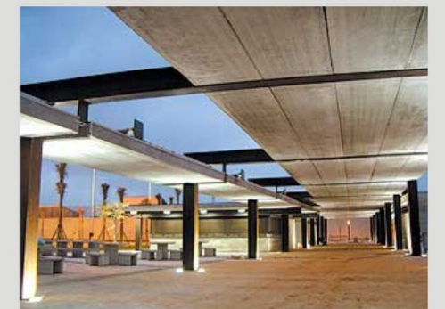
A marquise abriga lanchonete, vestiários e sanitários. FONTE: www.arcoweb.com.br
