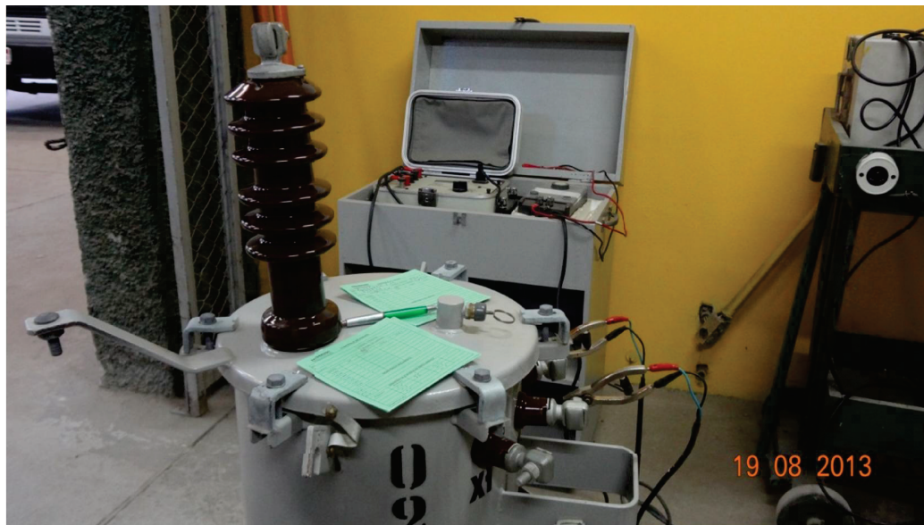
Figura 12 - Ensaio de resistência elétrica dos enrolamentos.
