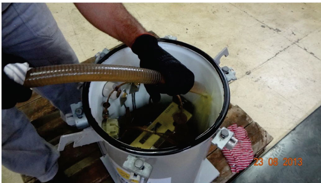
Figura 9 - Lavagem do transformador com óleo vegetal Biovolt® B.
