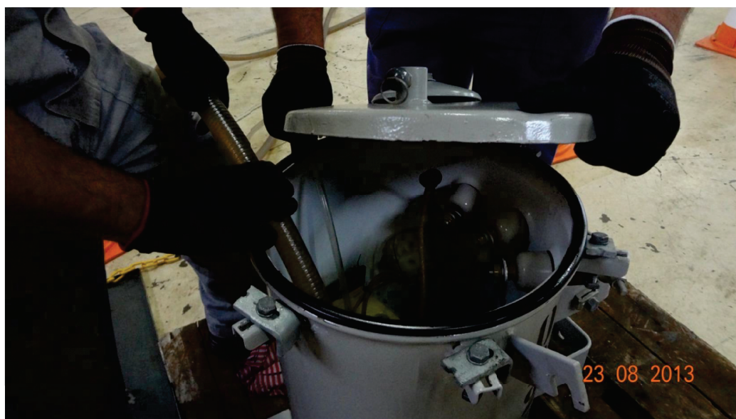
Figura 10 - Enchimento do transformador com adição de nitrogênio.
