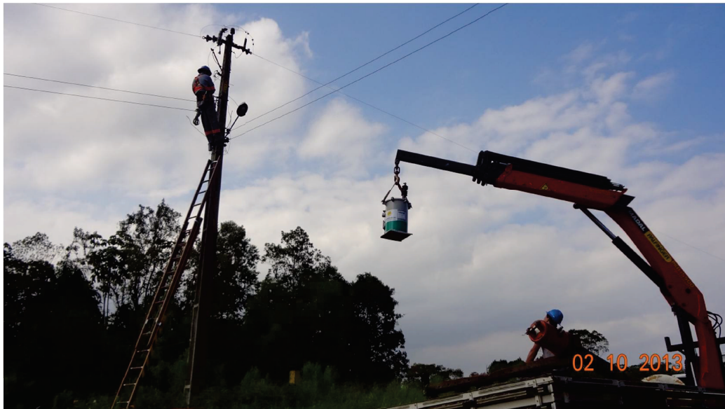
Figura 14 - Instalação do transformador na rede de distribuição.
