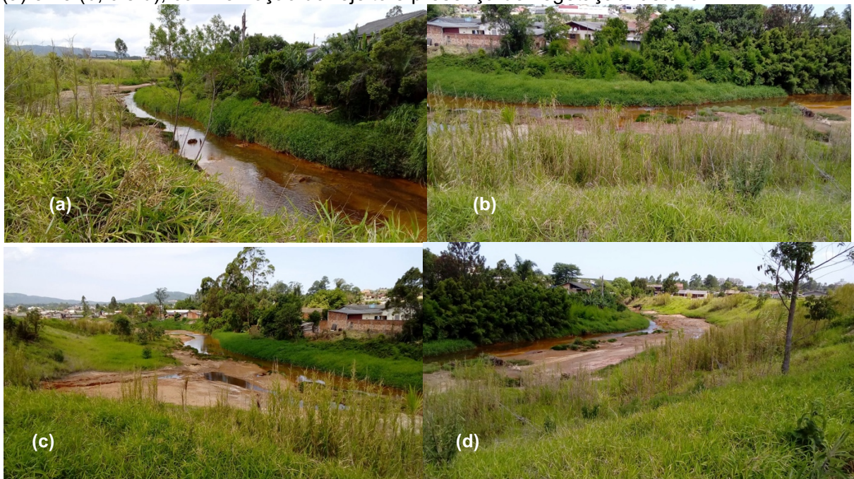
Figura 18 - Situação apresentada pela APP da margem direita do rio Sangão nos pontos 17 (a) e 18 (b, c e d), com remoção do rejeito e presença de vegetação rasteira
