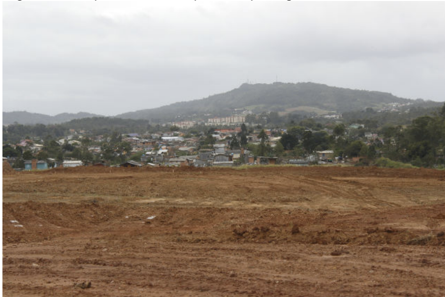
Figura 20 - Aspecto da área após terraplanagem
