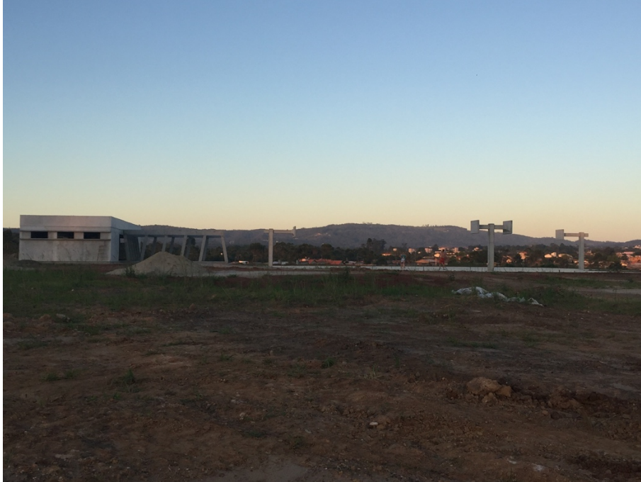
Figura 24 - Vista da área mostrando banheiros e quadras poliesportivas
