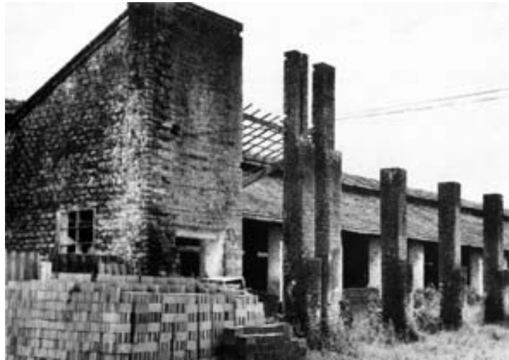
Figura 9 - Ruínas da Cerâmica São João, 1971
