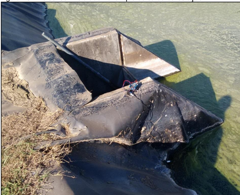
Figura 23 - Nó sensor instalado no tanque de saída da estação.
