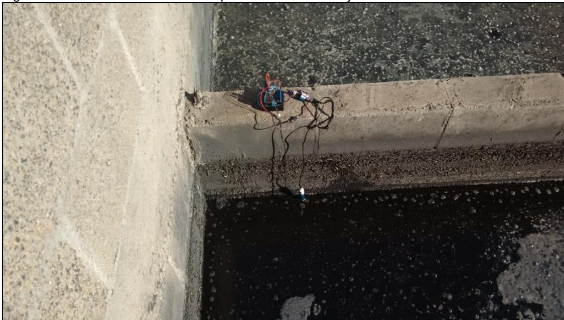
Figura 22 - Nó sensor instalado no tanque de entrada da estação.
