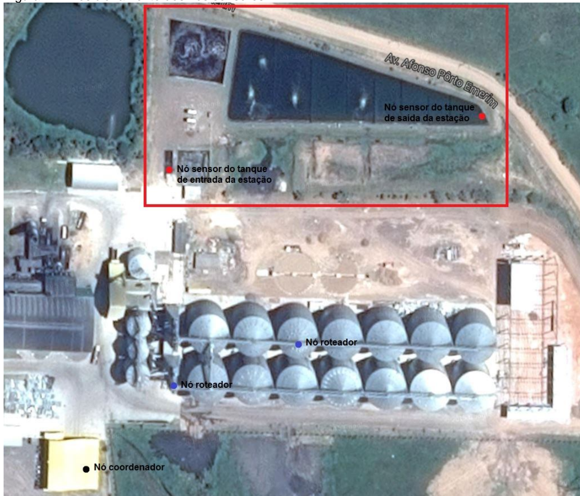
Figura 11 - Posicionamento dos nós sensores
