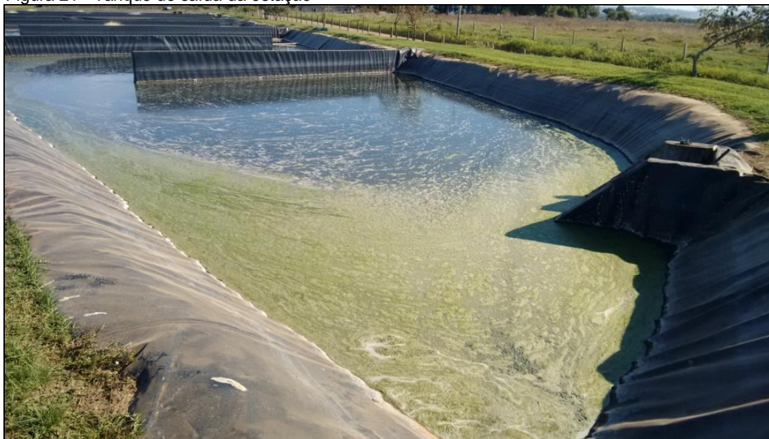
Figura 21 - Tanque de saída da estação
