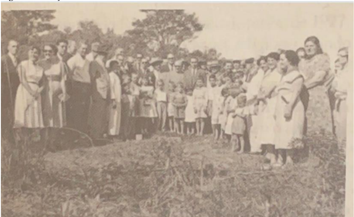
Figura 1 – Lançamento da Pedra Fundamental SCAN
