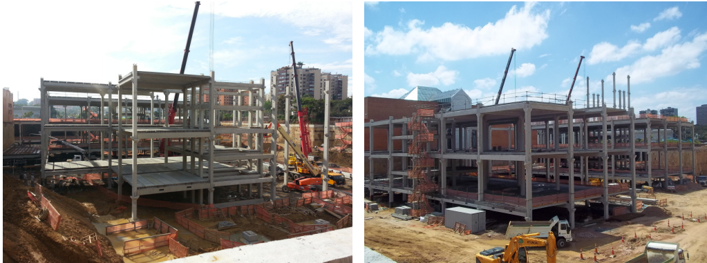
Figura 5: Fotos da montagem da obra (19/09/14).
