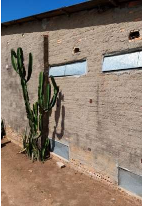
Figura 8 - Parte exterior da estufa elétrica
