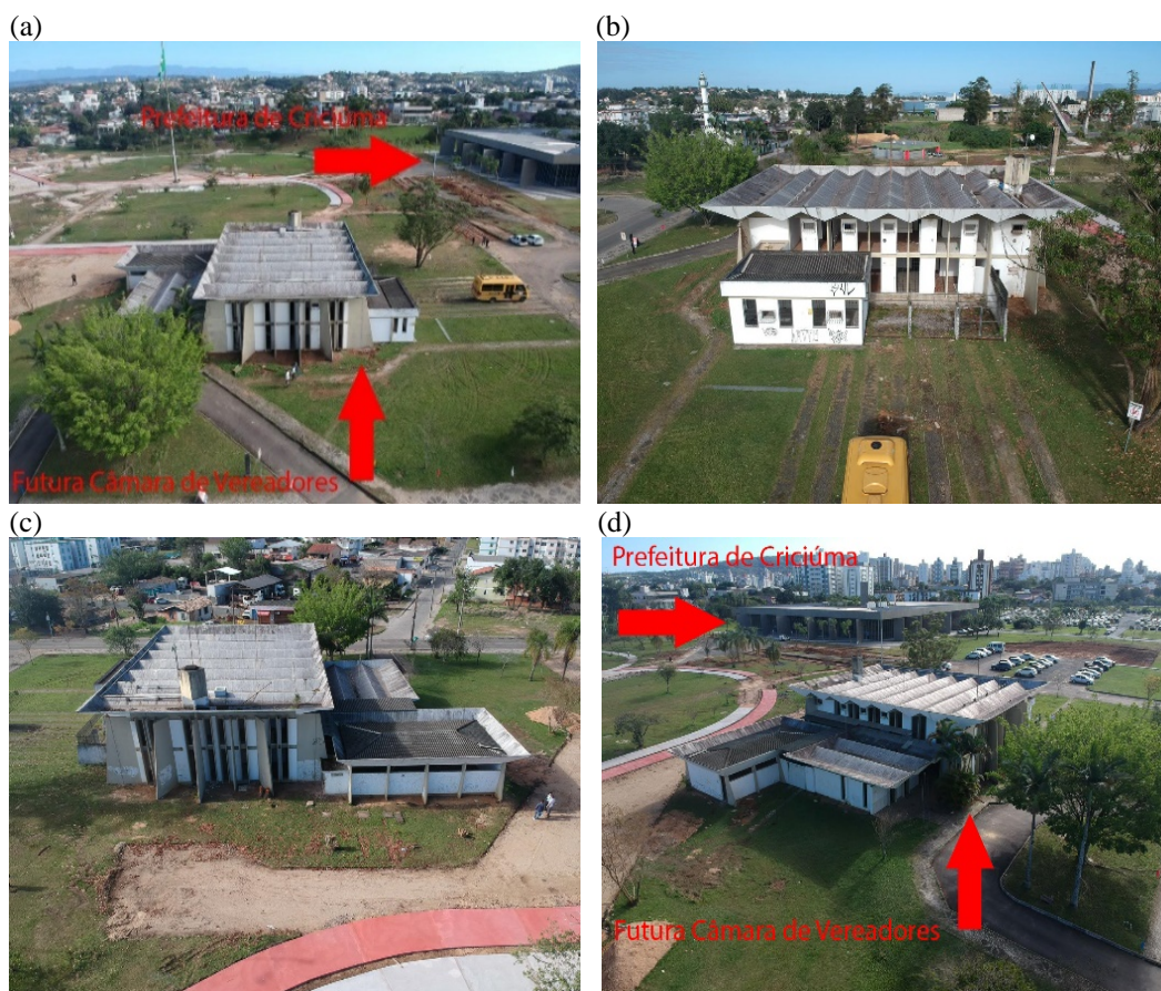
Figura 1. Fachadas: (a) principal, (b) lateral direita, (c) fundos, (d) lateral esquerda
