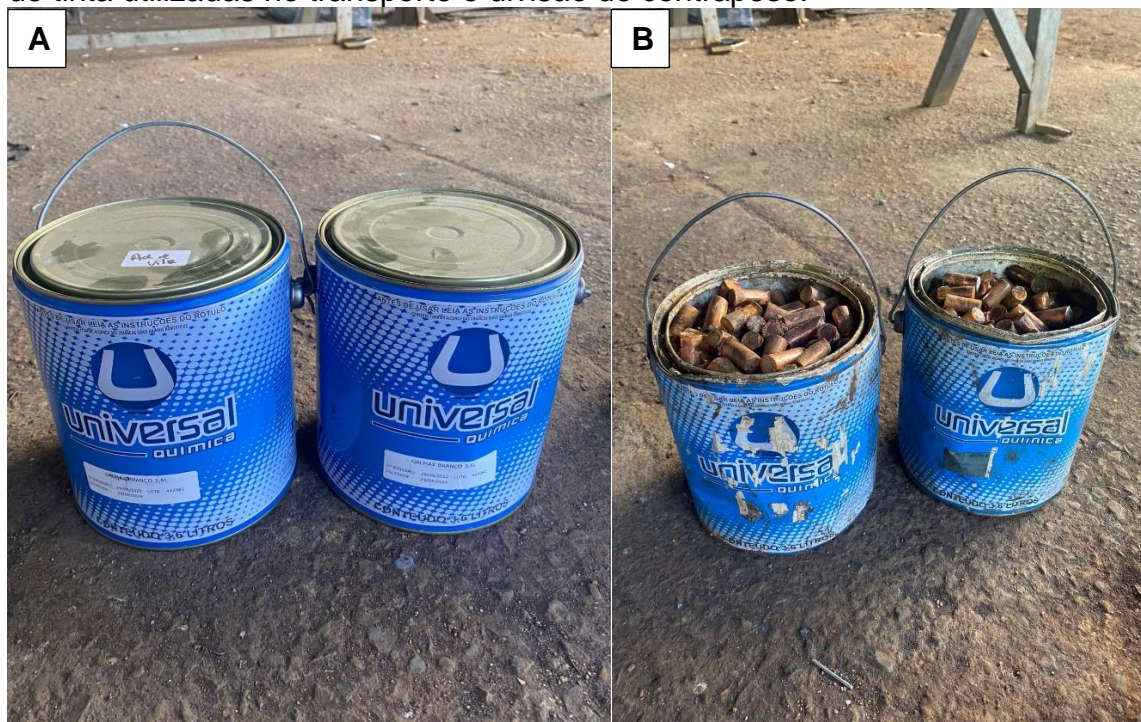
Figura 18: Reutilização das embalagens de tinta. A: Galões de tinta. B: Embalagens de tinta utilizadas no transporte e divisão de contrapeso.
