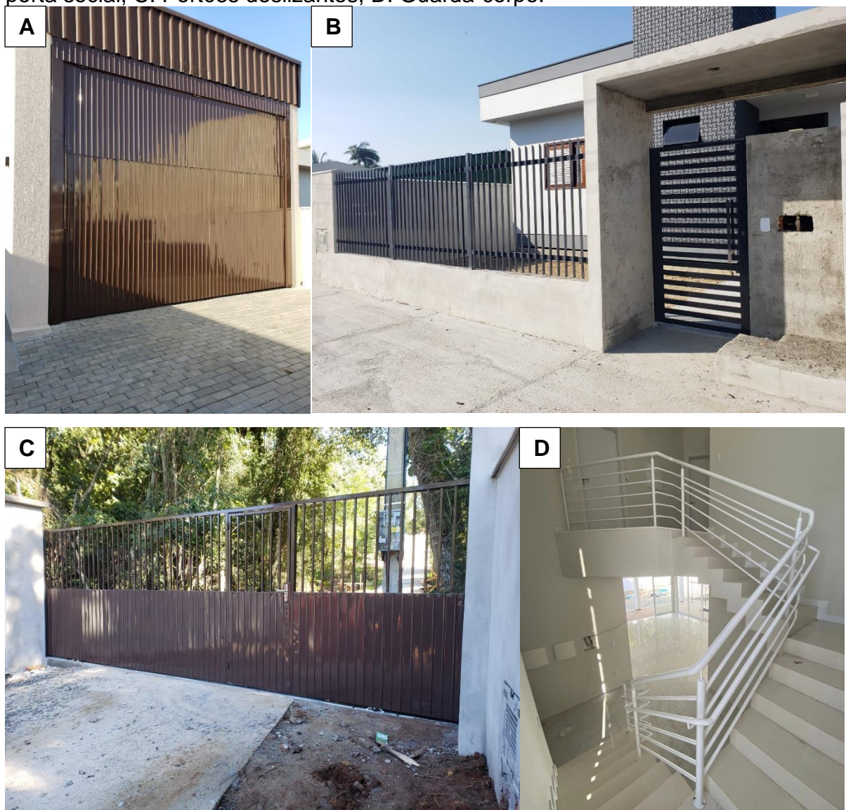
Figura 10: Exemplos de esquadrias já montadas, A: Portão basculante, B: Grades e porta social, C: Portões deslizantes, D: Guarda-corpo.
