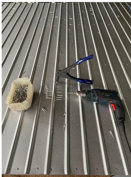
Figura 07: Fixação da chapa frisada na esquadria com arrebites de repuxo.
