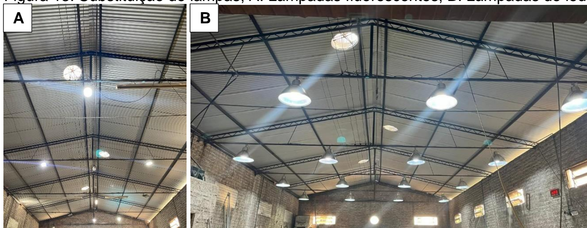
Figura 13: Substituição de lâmpas, A: Lâmpadas fluorescentes, B: Lâmpadas de led.
