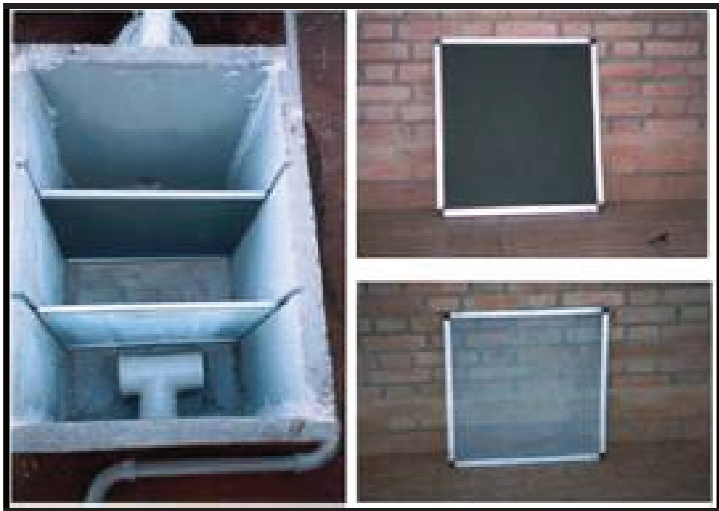
Figura 13 – Detalhamento do filtro e telas.
