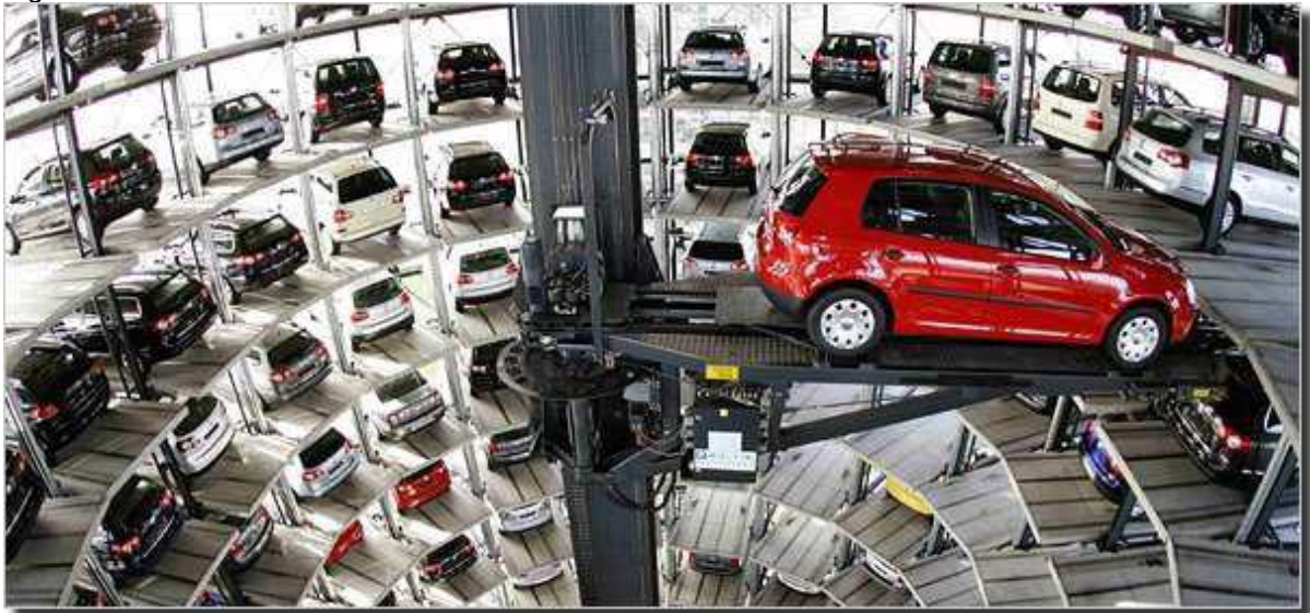
Figura 8 – Estacionamento vertical automatizado.
