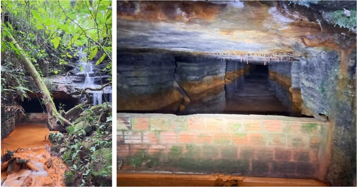
Figura 30 – Entrada da antiga mina Poeira
