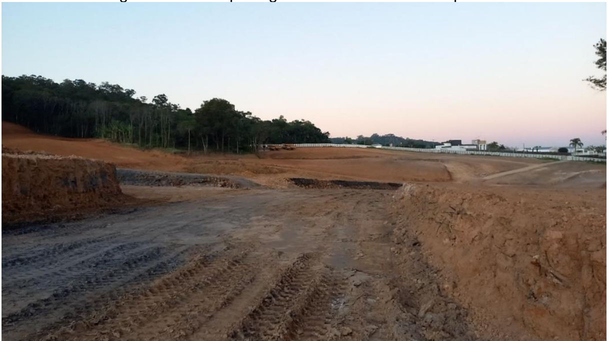
Figura 15 – Terraplanagem e cercamento com tapumes
