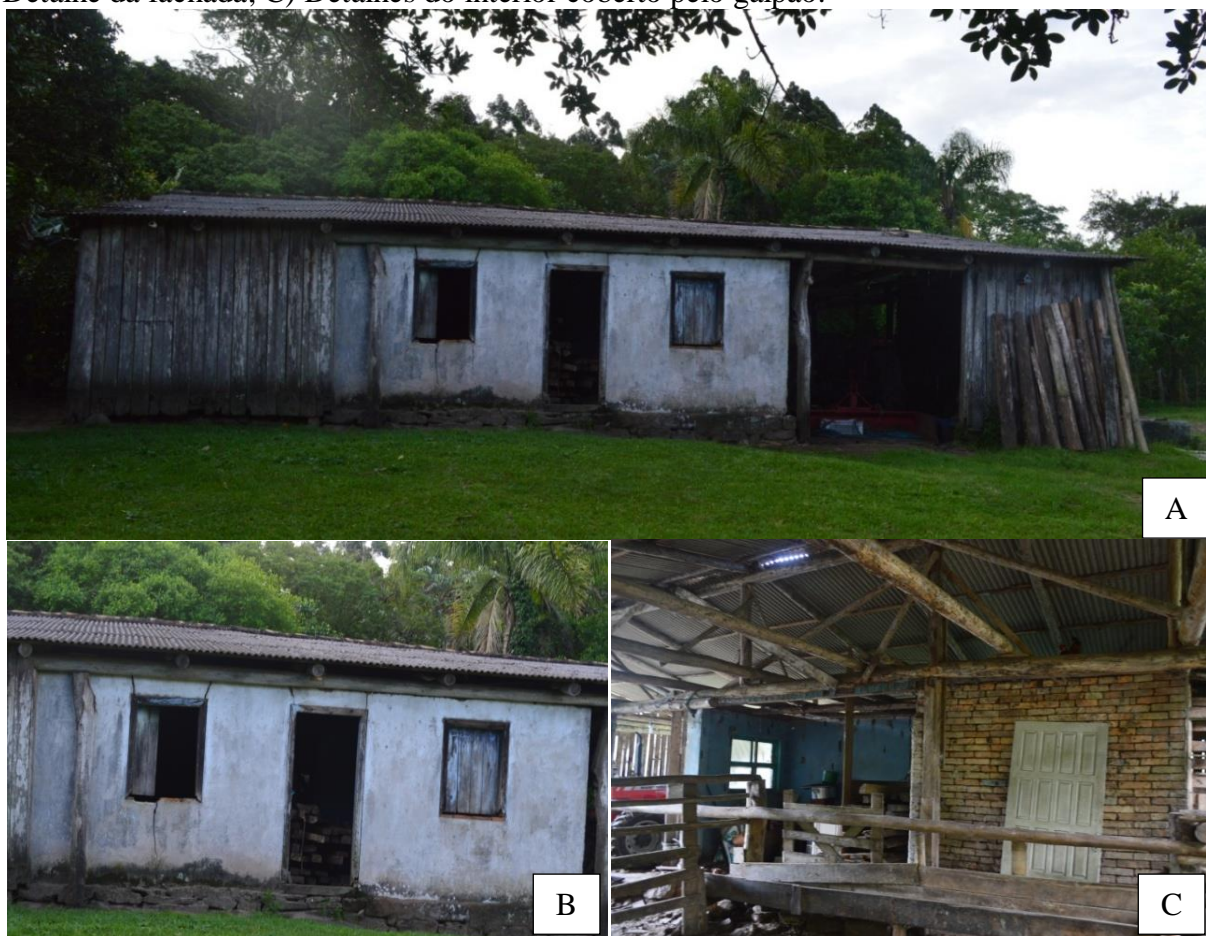
Figura 27: Imagens do sítio 24 – Casa Colonial (Família Perez). Onde: A) Vista ampla; B) Detalhe da fachada; C) Detalhes do interior coberto pelo galpão.
