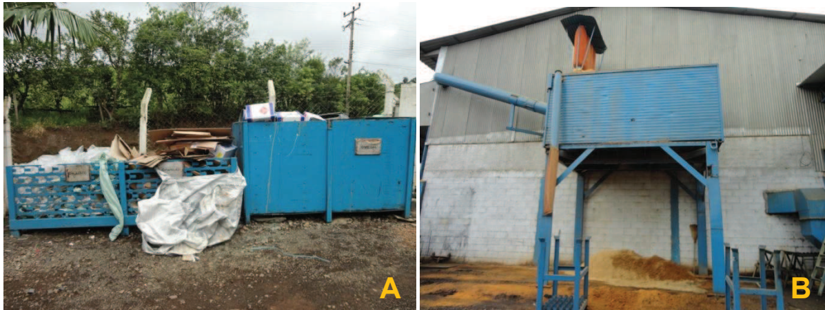
Figura 14 - Armazenamento temporário de resíduos recicláveis e cepilho da unidade.
