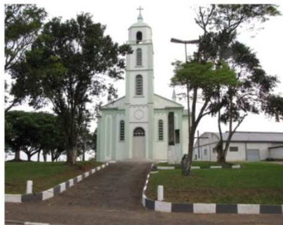
Igreja e centro comunitário – Cidade Mineira, Criciúma
