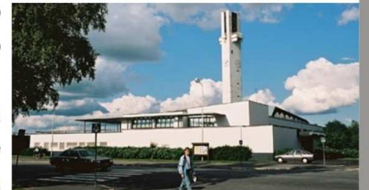
Igreja e campanário, vista da rua
