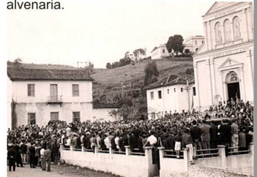
Figura16:Primeira Igreja construídas em alvenaria.
