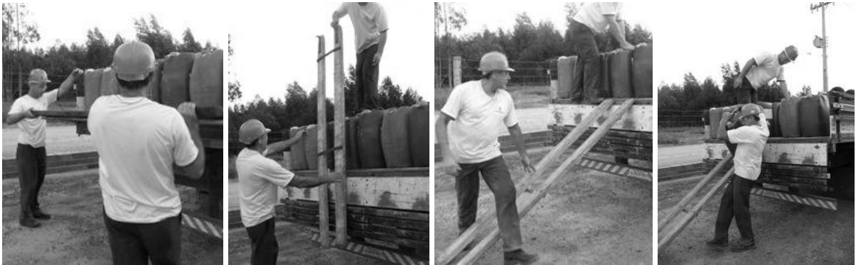
FIGURA 17: Descarga do Caminhão: Parte1. AUTOR (2011).
