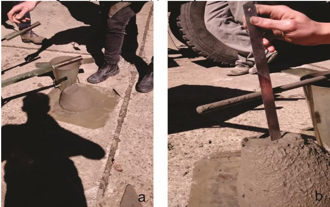
Figura 6: (a) slump test; (b) verificação do abatimento
