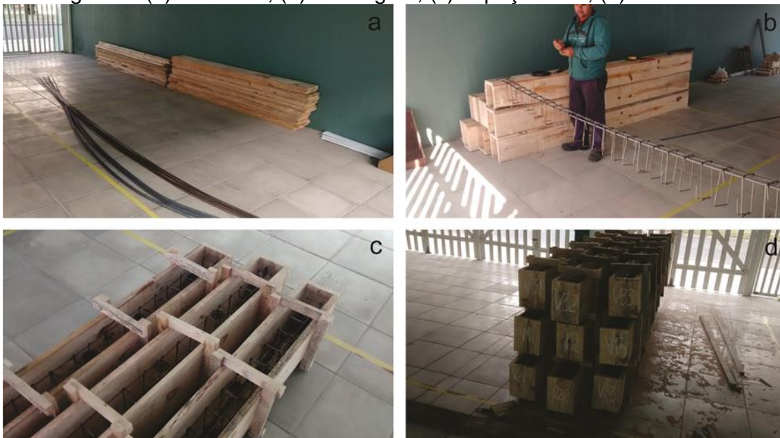
Figura 5: (a) materiais; (b) montagem; (c) espaçadores; (d) fôrmas
