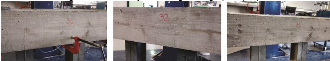
Figura 14: Fissuração das vigas do grupo B(FN)
