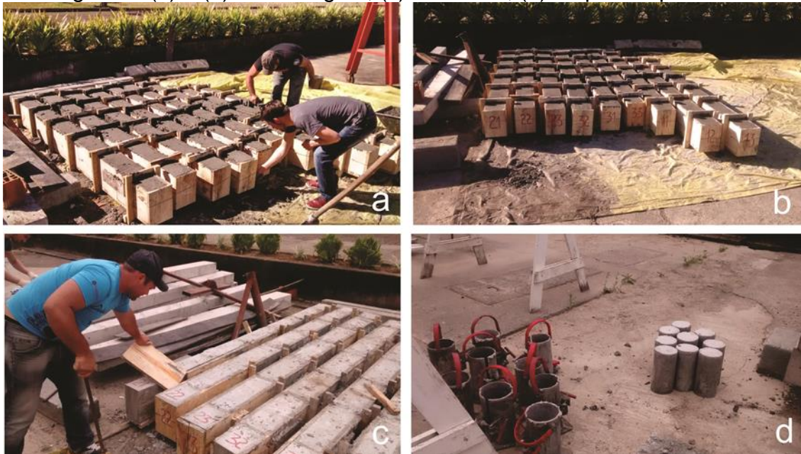
Figura 7: (a) e (b) concretagem; (c) desforma; (d) corpos de prova
