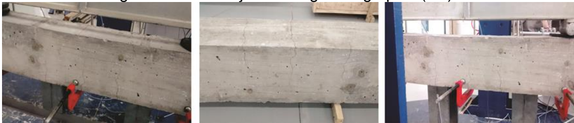
Figura 15: Fissuração das vigas do grupo C(SE)
