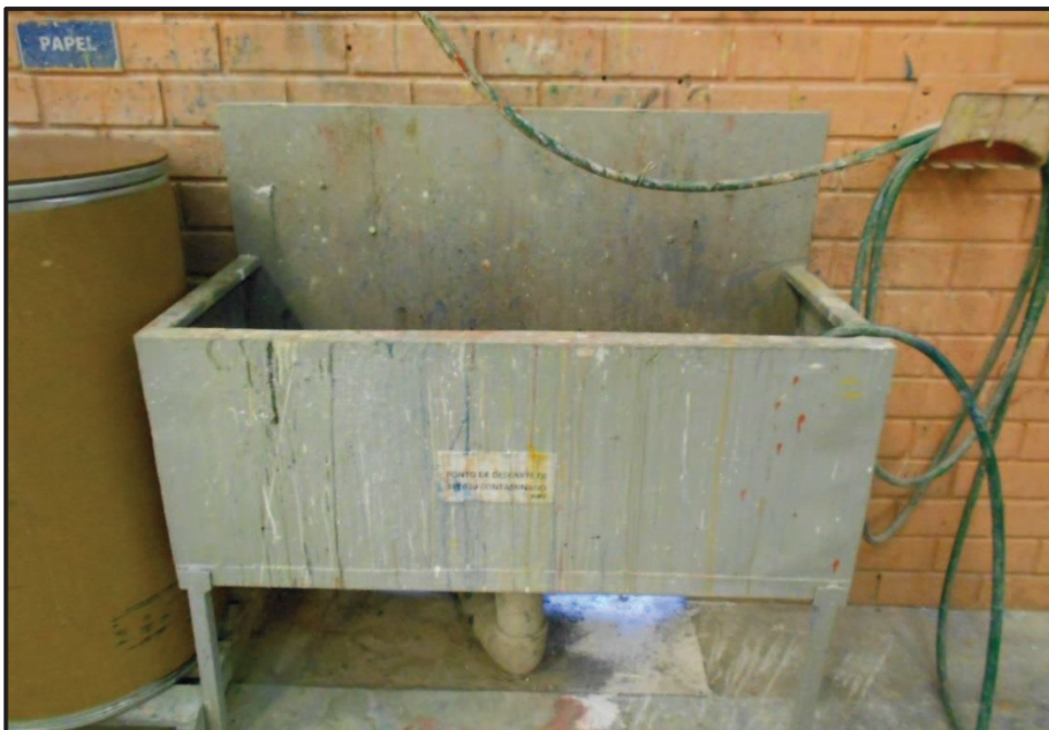
Figura 4 – Tanque de descarte para limpeza de equipamentos.
