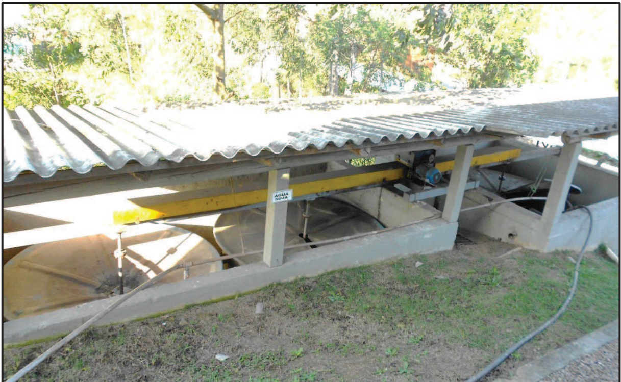
Figura 8 – Reservatórios de recebimento do efluente para posterior tratamento.
