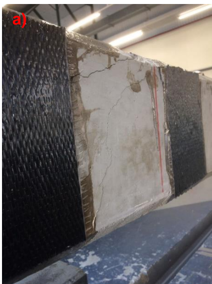
Figura 09(a) – V1 colapsada após reforço.
