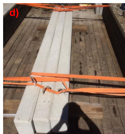
Figura 02(d) – Vigas concretadas
