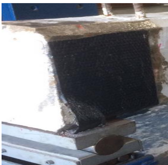
Figura 16 – Fibra deslocada da viga após aplicação de carga.
