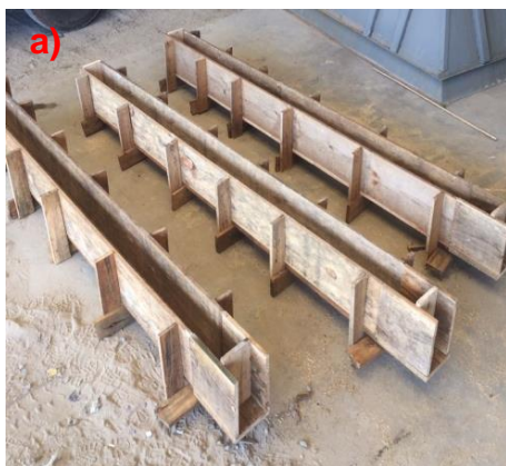
Figura 02(a) – Formas para concretagem
