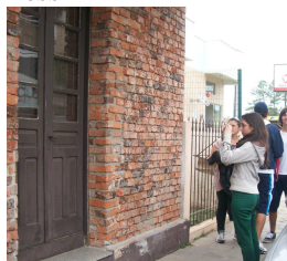
Figura 07: Fachada na rua Alfredo Pessi
