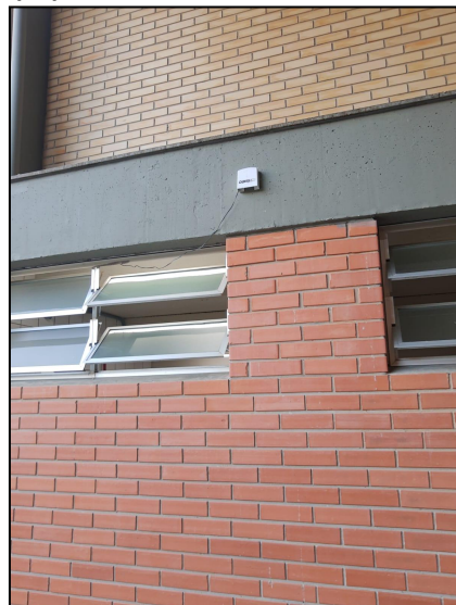
Figura 05 - Instalação do equipamento AirLink .
