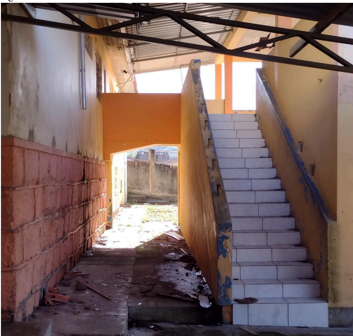
Figura 11 – Interior da escola
