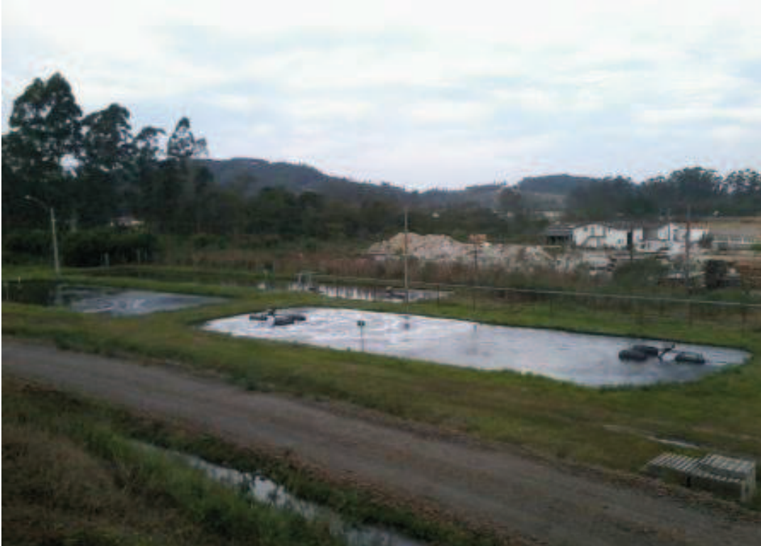
Figura 41 – Lagoas da ETE
