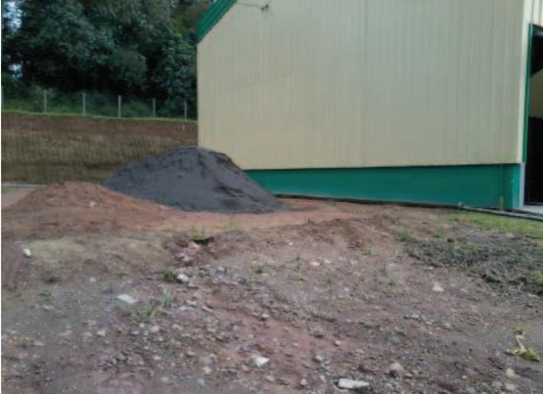
Figura 34 – Preparação para a construção do depósito intermediário de resíduos
