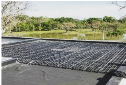
Figura 11a e 11b – Módulo laminar médio do telhado verde e Esquemático do sistema
