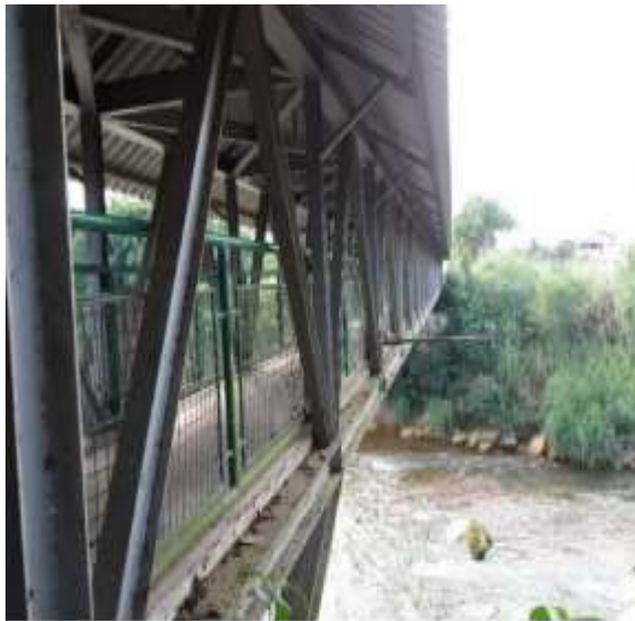
Figura 2 – Antiga passarela sobre o Rio Mãe Luzia
