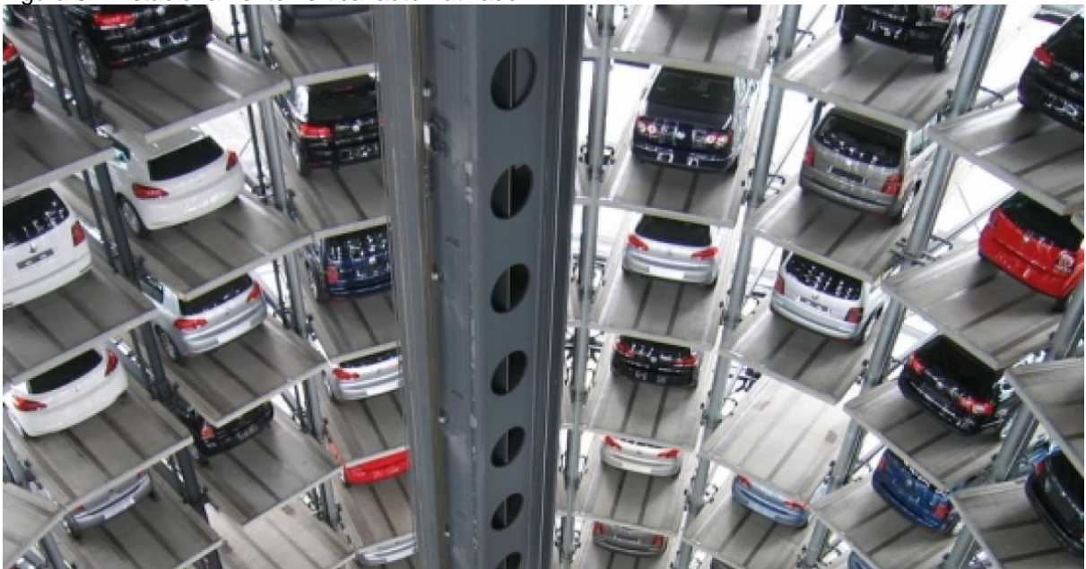
Figura 3 – Estacionamento vertical automatizado
