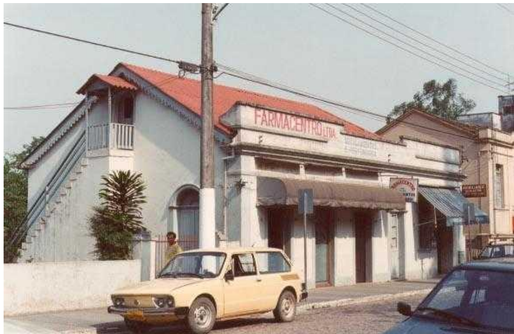
Figura 9 - Edificação Praça Anita Garibaldi, 73, Processo de Tombamento nº 184/2000.
