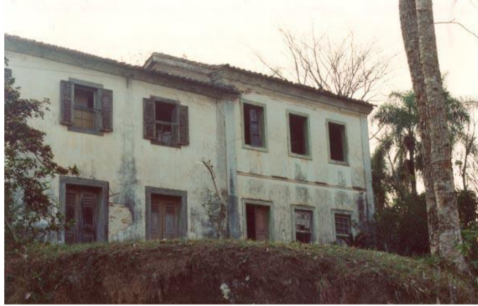
Figura 5 - Edificação na Rodovia SC446-km 11, Rio Maior.
