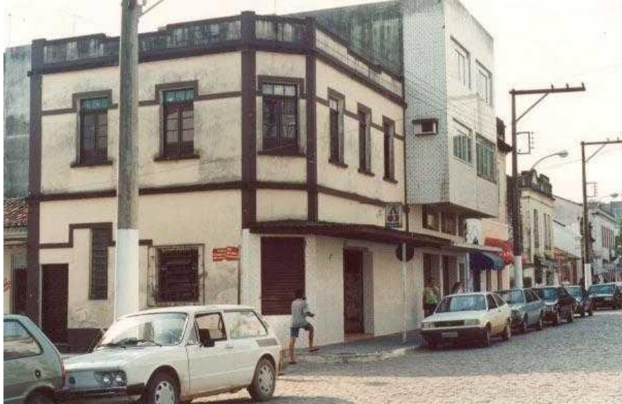
Figura 11 - Edificação na Praça Anita Garibaldi com Rua Domingos da Rocha, 285
