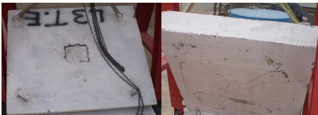
Figura 9- ruptura das lajes.
