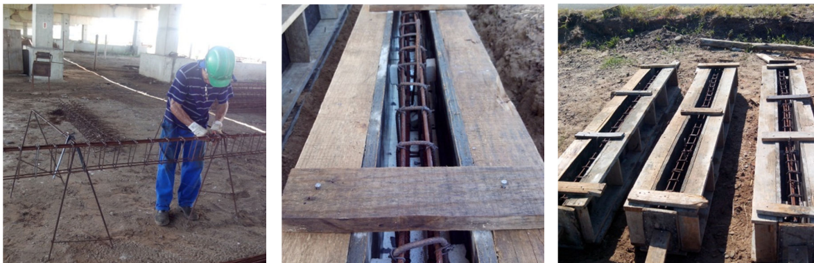
Figura 4 – (a) Montagem das armaduras; (b) Espaçadores; (c) Formas;
