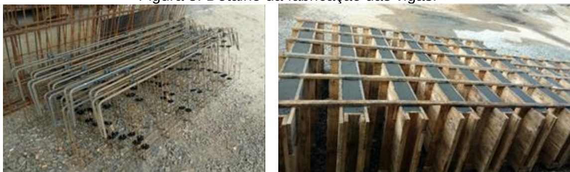
Figura 3: Detalhe da fabricação das vigas.
