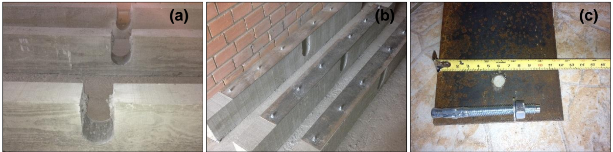
Figura 4: Confeção das vigas de concreto armado
