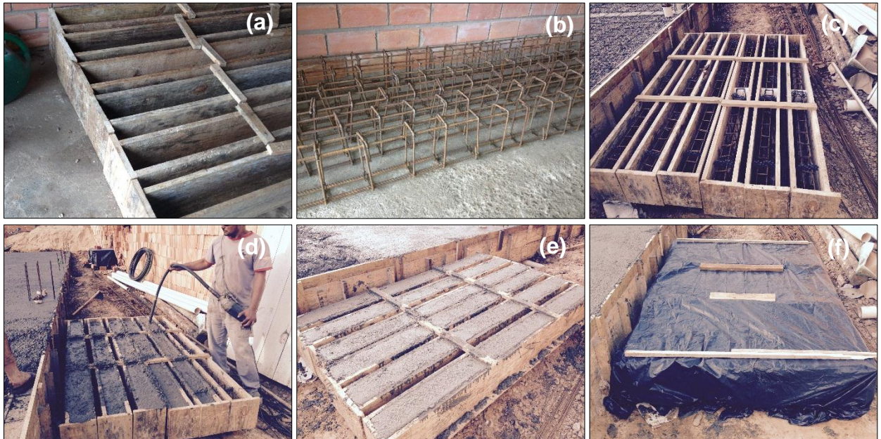
Figura 2: Confeção das vigas de concreto armado
