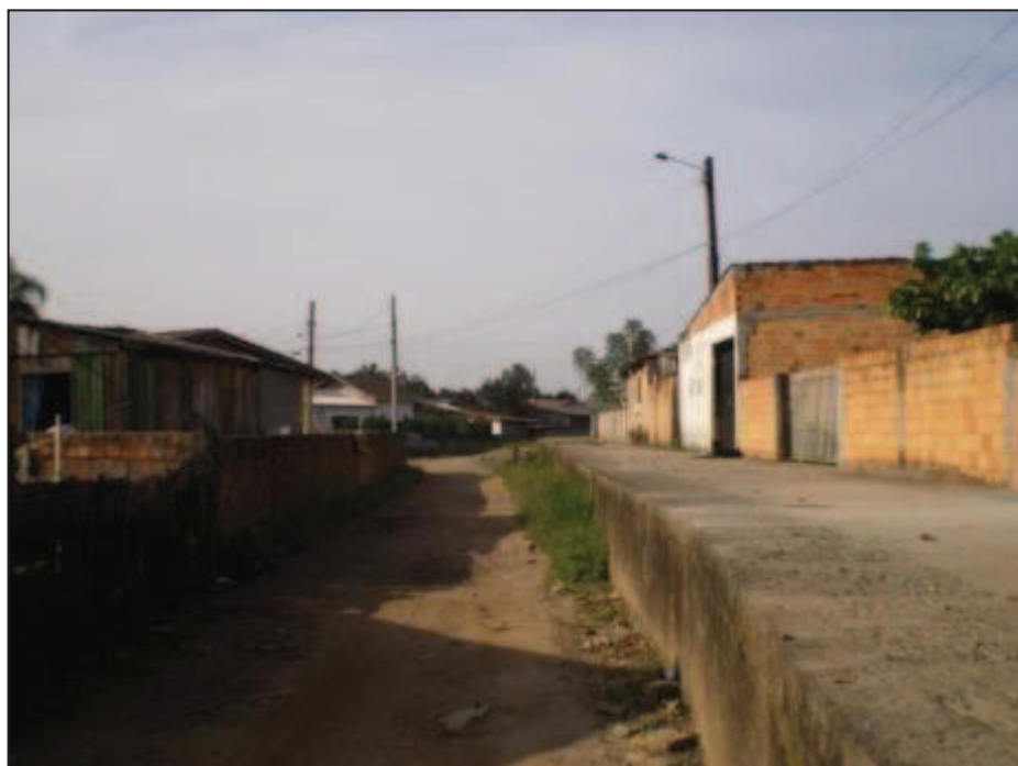
Figura 8- Região apresentada na Figura 07, após a construção do canal
