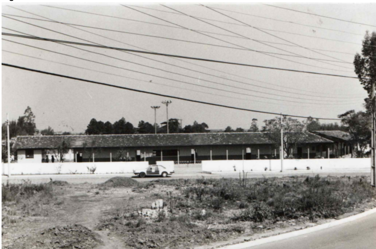
Figura 11 - Primeiro aumento nas salas de aula da escola de alvenaria.
