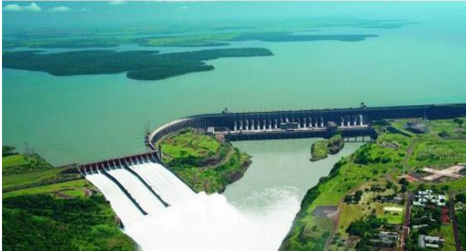
Figura 1: Usina de Itaipu
