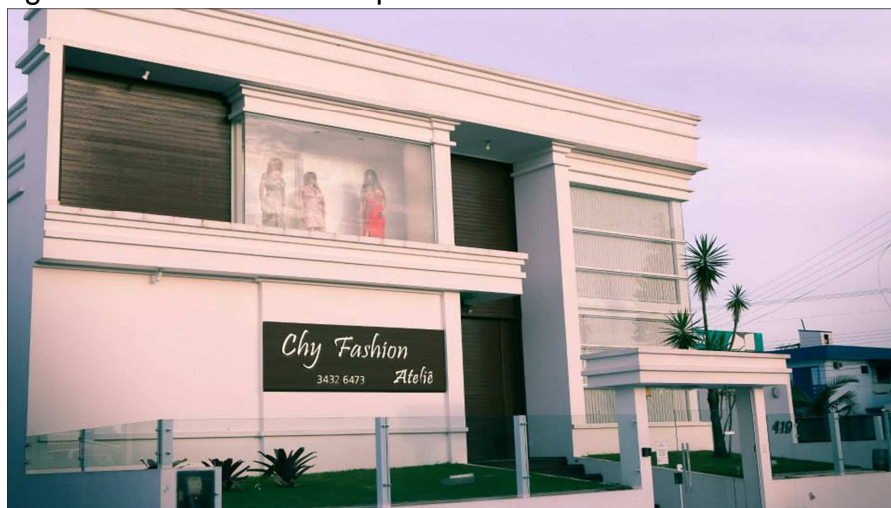
Figura 2 – Fachada da Empresa
